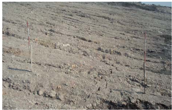
เครื่องมือ Crack Monitor ก่อนการปรับปรุง
