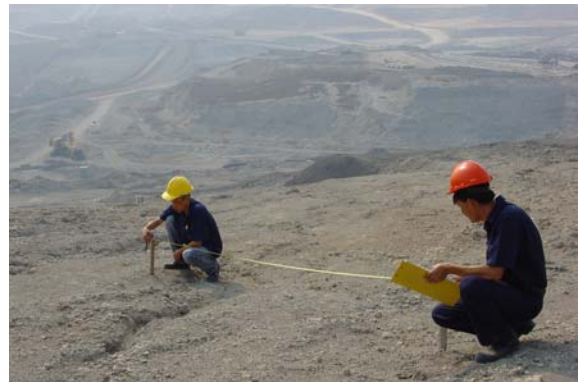
การตรวจวัดข้อมูลการเคลื่อนตัวผิวดิน ของผนังบ่อเหมืองแม่เมาะด้วยเครื่องมือ Crack Monitor
