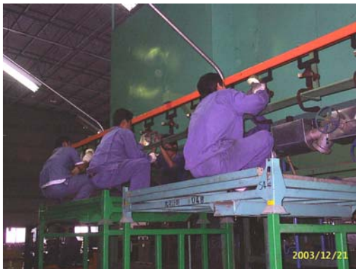
พนักงานขึ้นไปขัดบน Shelf โดยใช้กระดาษทรายขัดปีกทองเหลือง
